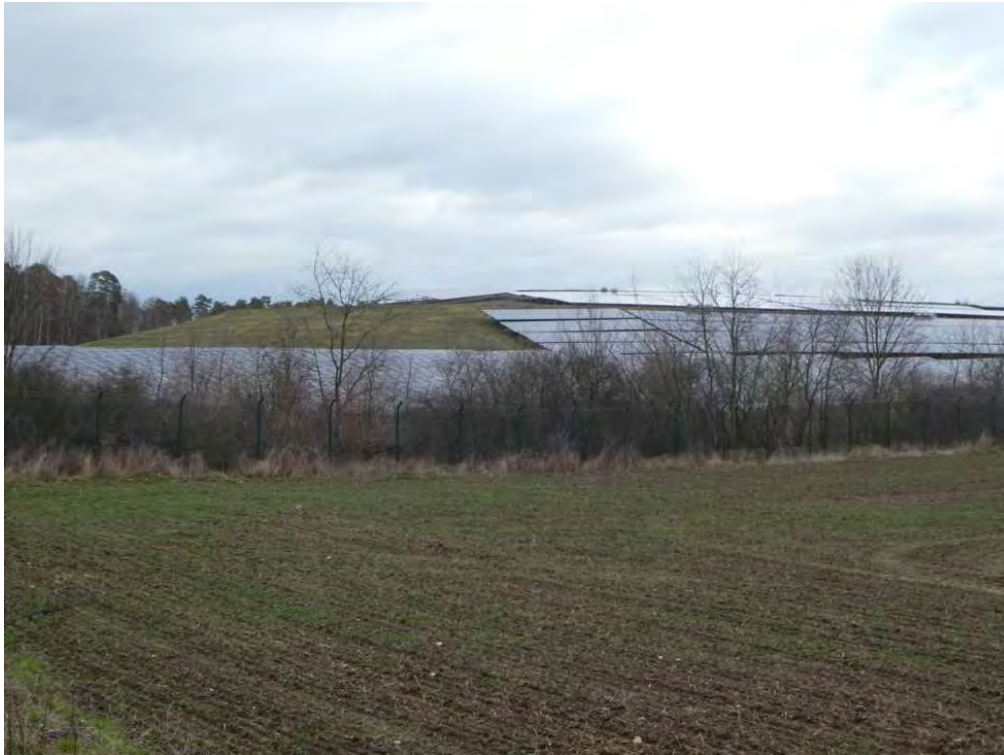
Foto 8. Photovoltaik-Freifl6chenanlage auf der stillgelegten und abgedeckten fr6heren Hausm6lldeponie G6ritz. – Foto: R. M6ckel
